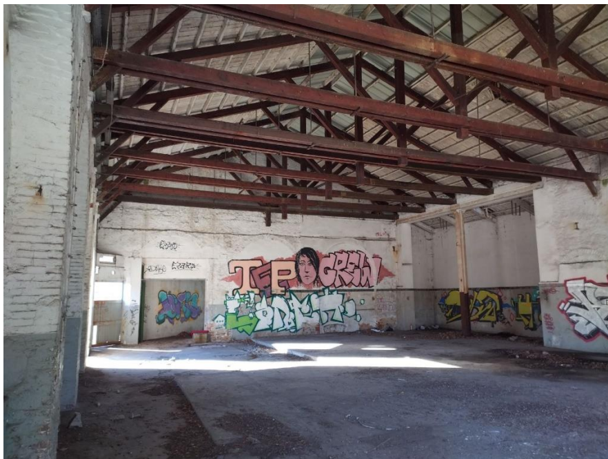
Figure 9 : La Halle Nord conservée, vue depuis l'intérieur
